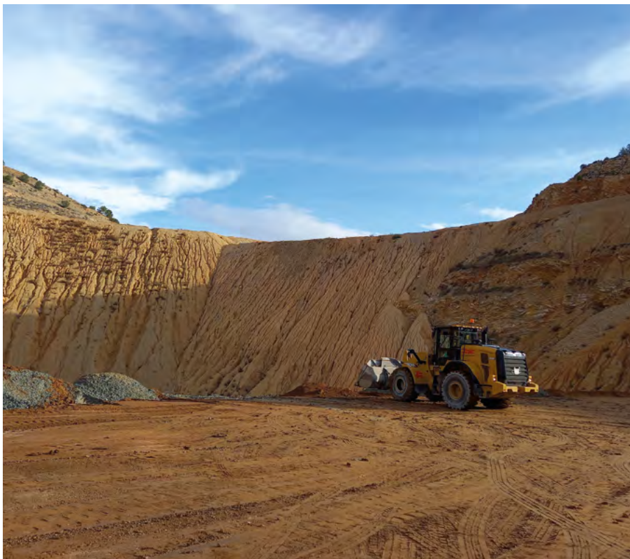
A la pedrera Cal Tita s'han gestionat 40.000 tones de terres d'excavació
