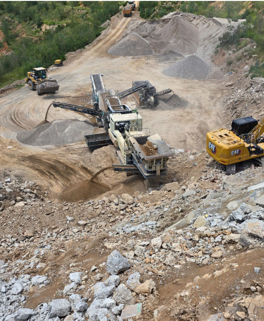
Operacions de valorització de runes en dipòsit controlat
