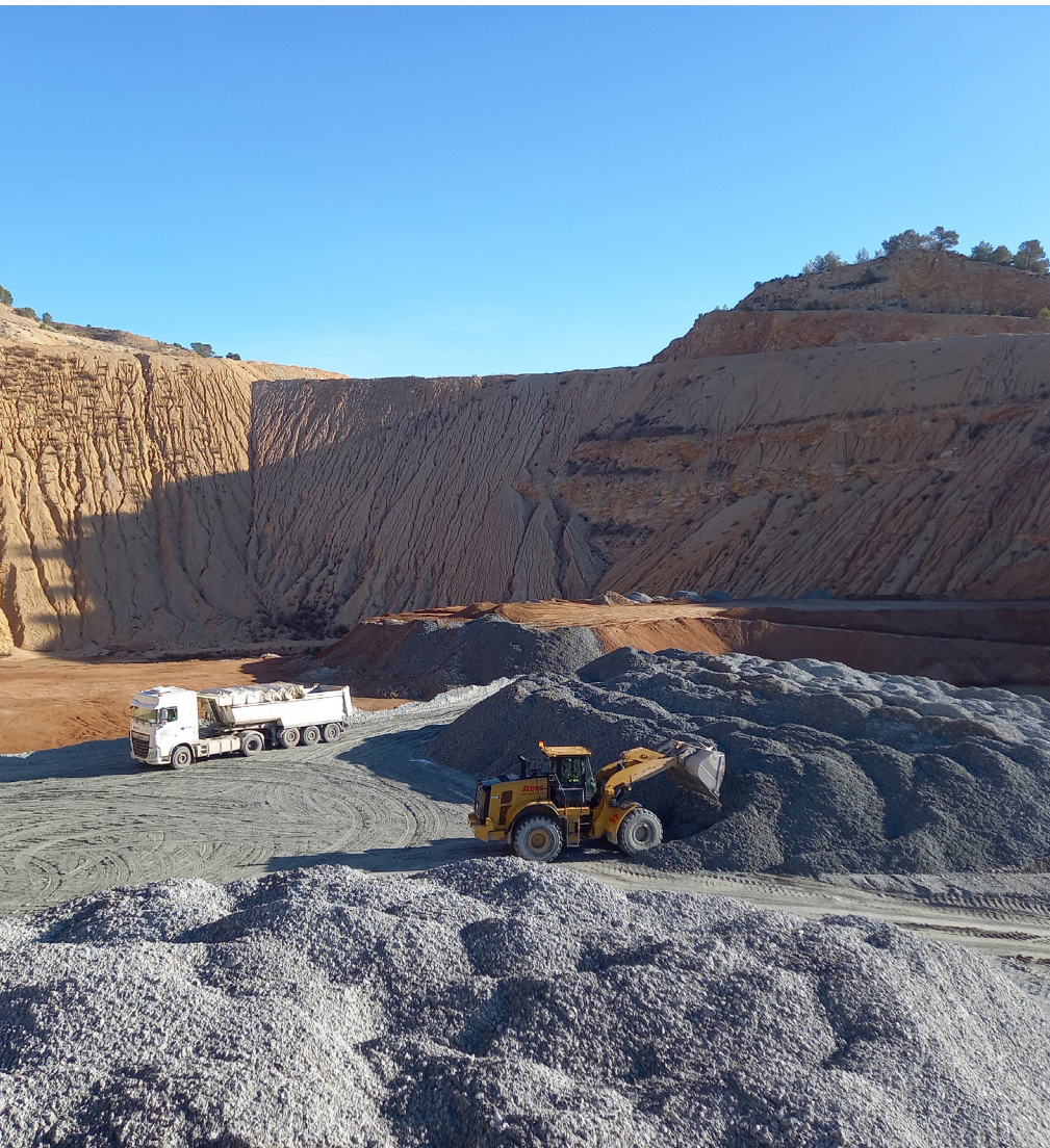
Restauració de la pedrera Cal Tita a Cervelló
