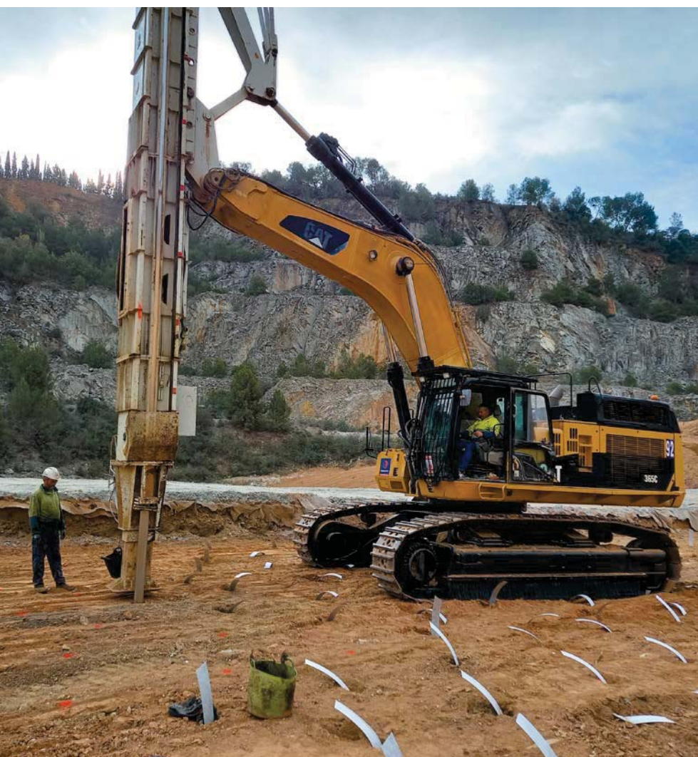
Instal·lació de geodrens per estabilitzar el rebliment a la pedrera Berta
