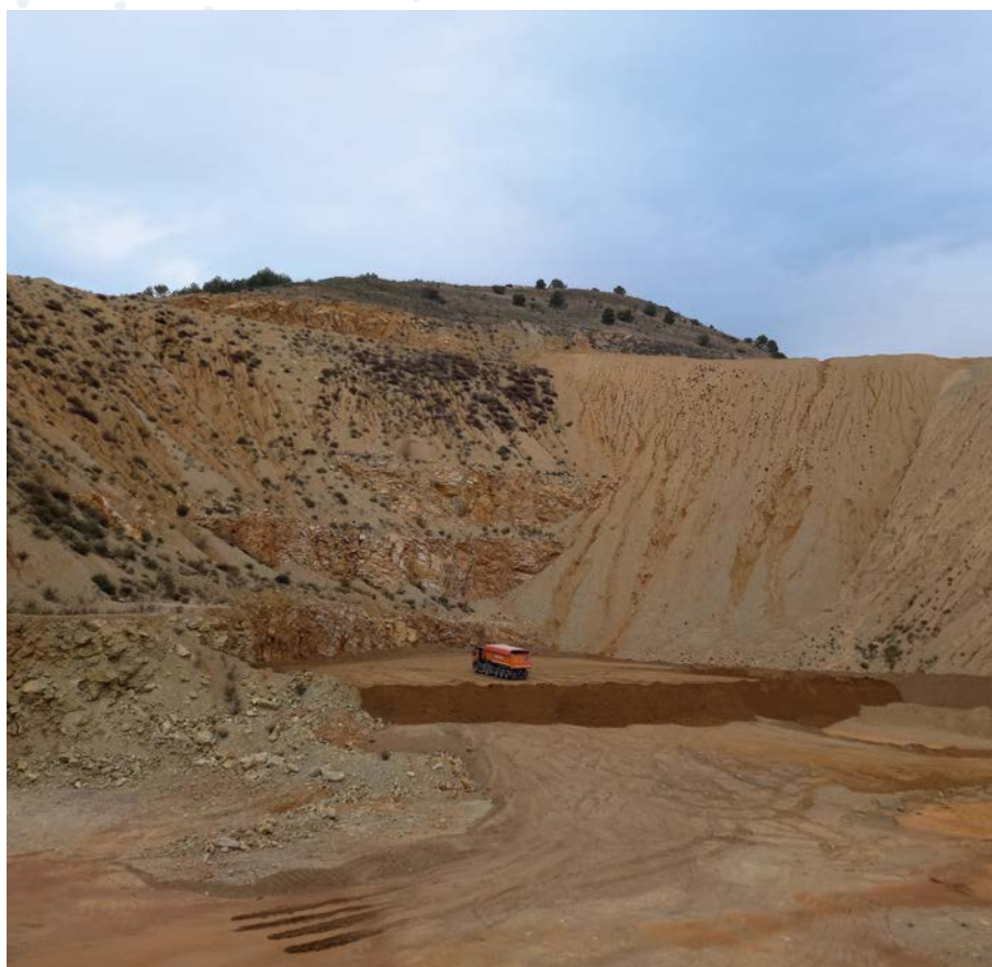
A Cervelló, la restauració de la pedrera Cal Tita es fa amb l'aportació de terres netes de rebaix
