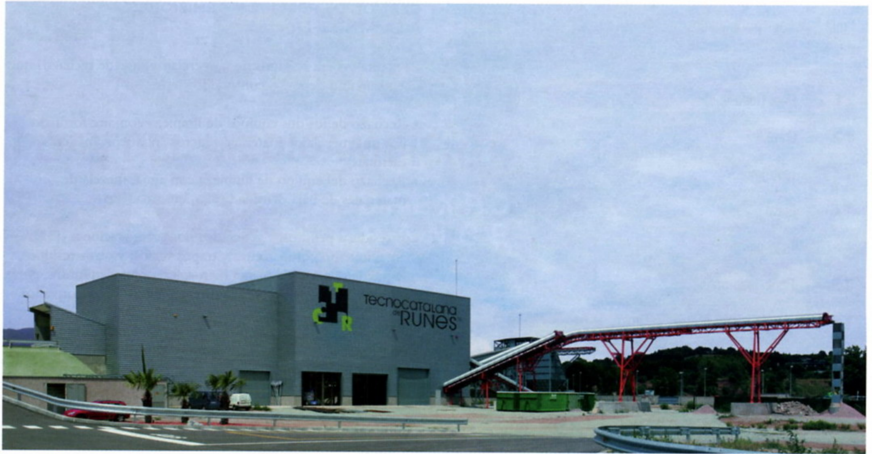
Vista exterior de la planta
